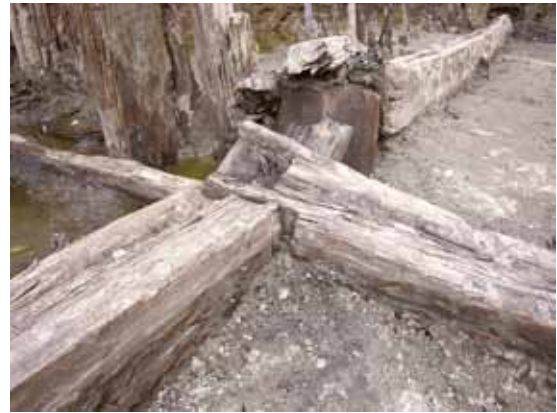
Ryc. 52. Przykład translokacji przyciesi w wyniku m.in. procesów podepozycyjnych w północno-wschodnim narożniku sieni domu III. Fot. R. Krzywdziński
