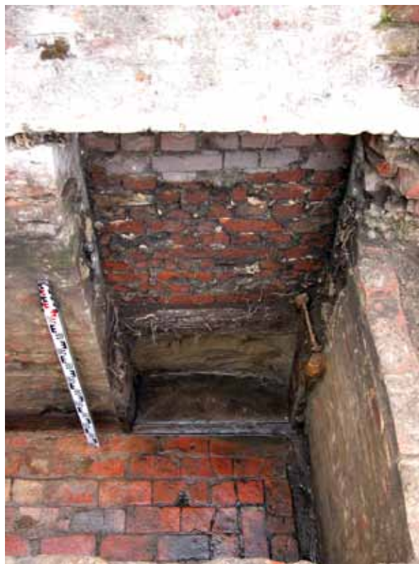
Ryc. 174. Pozostałości obmurowanego zagłębienia – zejścia w południowej części wschodniego traktu (pomieszczenie 21) na niższy poziom pomieszczenia 10 z traktu zachodniego piwnicy kamienicy przy ul. Św. Ducha 43. Widoczna zamurowana oścież. Widok od wschodu. Fot. R. Krzywdziński
