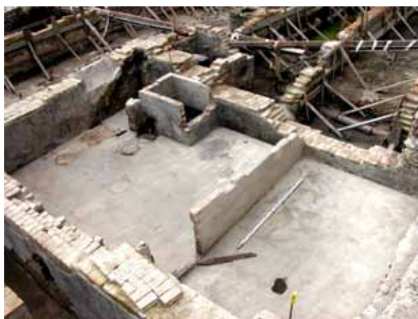
Ryc. 168. Południowa część zachodniego traktu piwnicy (pomieszczenia 17 i 18) kamienicy przy ul. Św. Ducha 43. Widok od północnego zachodu. Fot. R. Krzywdziński
