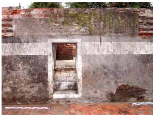
Ryc. 167. Oścież łącząca pomieszczenie 8 z 20 w piwnicy kamienicy przy ul. Św. Ducha 43. Widok od zachodu (od strony pomieszczenia 8). Fot. R. Krzywdziński
