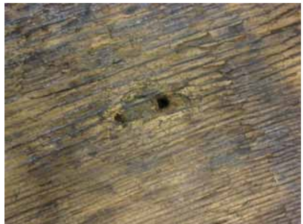
Ryc. 9. Ślad po zagięciu gwoździa, świadczący prawdopodobnie o pierwotnym mocowaniu w tym miejscu drugiej poprzecznej deski. Fot. K. Darecka
