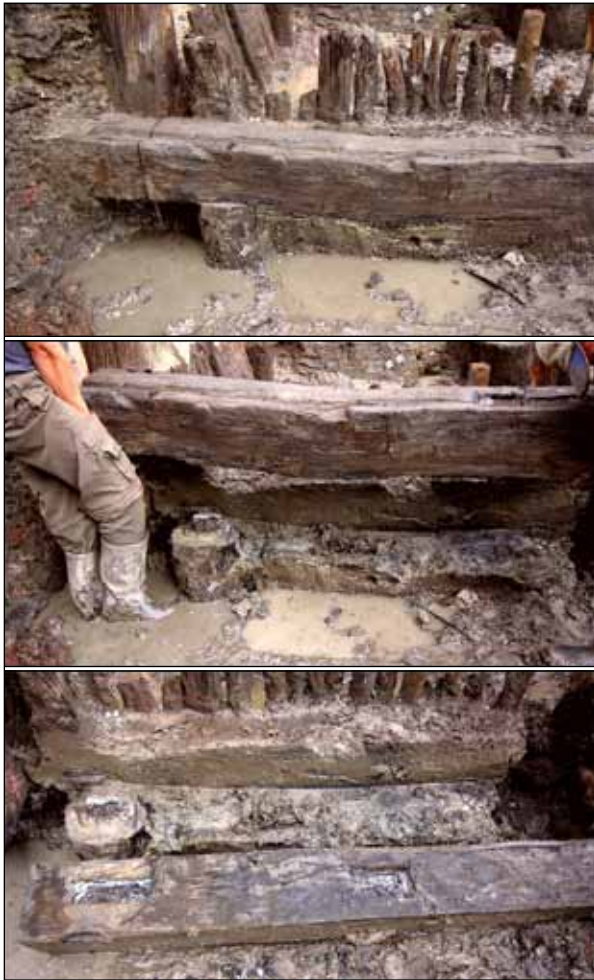
Ryc. 44. Sposób łączenia przyciesi domu III z palami. Na dolnej powierzchni belki podwalinowej widoczne dwa gniazda (fotografia dolna), z czego tylko jedno było wykorzystane. Fot. R. Krzywdziński
