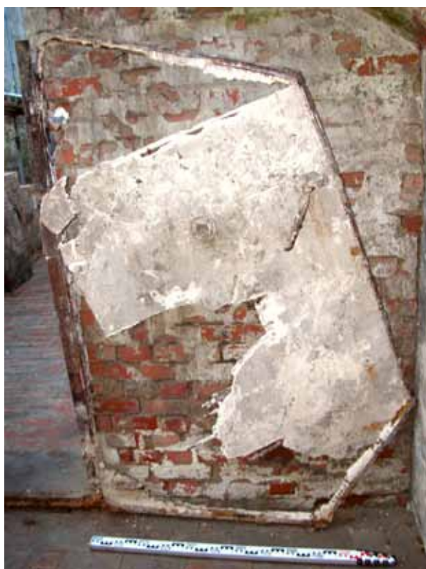
Ryc. 162. Drzwi z południowej ściany pomieszczenia 2 w piwnicy kamienicy przy ul. Św. Ducha 43. Fot. R. Krzywdziński
