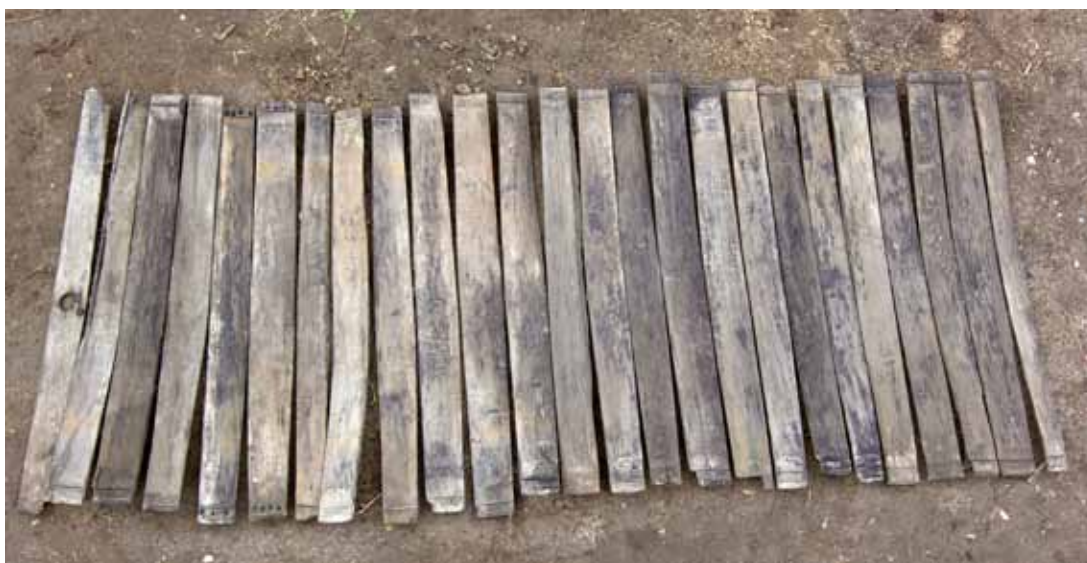
Ryc. 61. Klepki studni 1 z zaplecza działki C po demontażu. Fot. R. Krzywdziński
