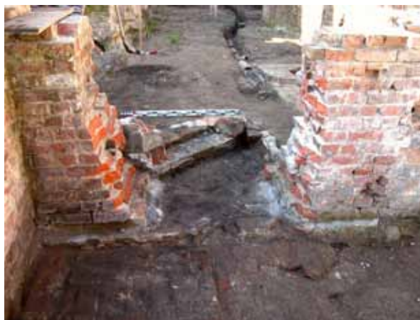
Ryc. 172. Pozostałości ceglanych schodów zabiegowych prowadzących na zaplecze domu przy południowej części wschodniego traktu piwnicy (pomieszczenie 21) kamienicy przy ul. Św. Ducha 43. Widok od północy. Fot. R. Krzywdziński
