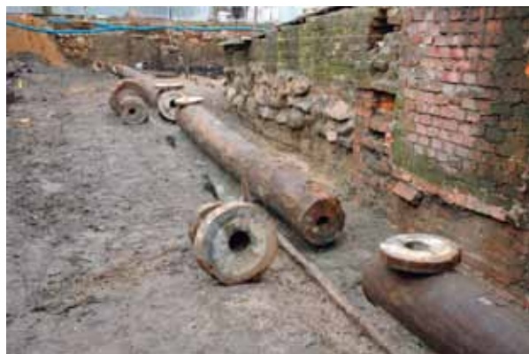
Ryc. 149. Pozostałości wodociągu pod nawierzchni wschodniego przejścia jatek rzeźniczych z VII poziomu osadniczego podczas pobierania prób do badań dendrochronologicznych. Widok od północnego wschodu. Fot. A. Firynowicz
