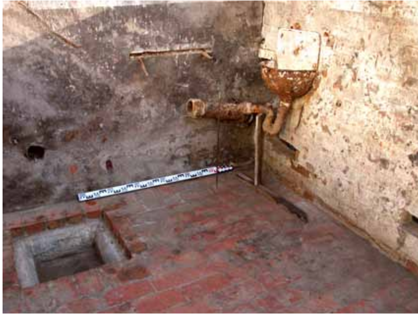
Ryc. 164. Północno-wschodni narożnik pomieszczenia 8 ze zlewem w piwnicy kamienicy przy ul. Św. Ducha 43. Widok od południowego zachodu Fot. R. Krzywdziński
