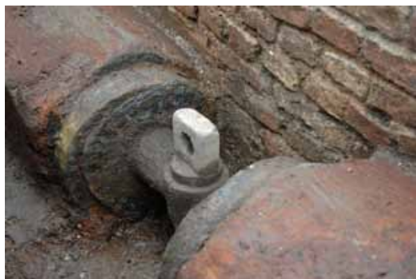
Ryc. 21. Św. Ducha 44: widok na złączkę łączącą dwa odcinki drewnianych rur wodocięgowych doprowadzających wodę do XVII-wiecznej kamienicy. Widok od SW
