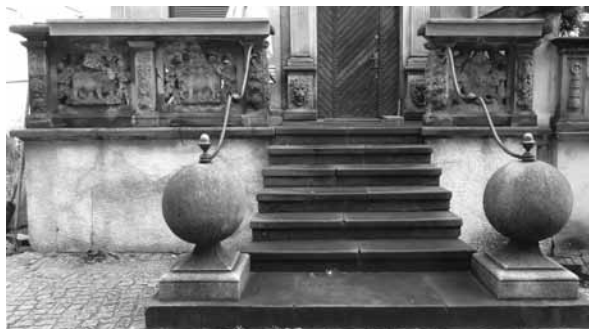
Ryc. 1. Przedproże kamienicy przy ul. Mariackiej 52, stan obecny. Fot. E. Nakonieczna
