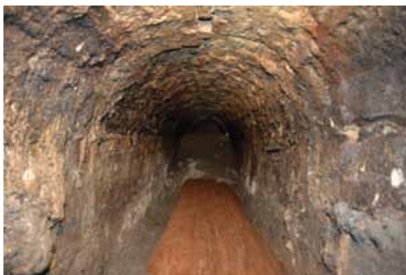
Ryc. 20. Św. Ducha 44: widok na wnętrze ceglanego kanału doprowadzającego drewniany wodociąg do XVII-wiecznej kamienicy. Widok od S
