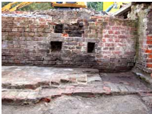
Ryc. 171. Południowa część wschodniego traktu piwnicy (pomieszczenie 21) kamienicy przy ul. Św. Ducha 43. Pozostałości murowanego pieca grzewczego z wylotem przewodów kominowych. Widok od zachodu. Fot. R. Krzywdziński
