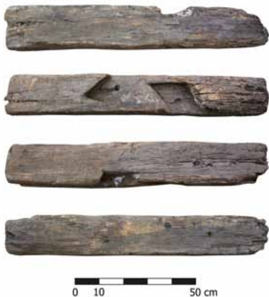
Ryc. 47. Wtórnie użyta belka jako wzmocnienie lub naprawa konstrukcji zachodniej ściany domu I w fazie A II poziomu osadniczego. Fot. R. Krzywdziński
