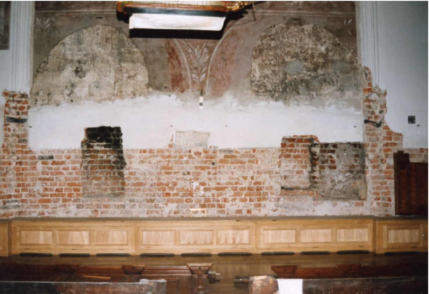
25. Ława św. Krzysztofa podczas instalacji boazerii i rekonstrukcji siedzisk, 1993–1994, MG
