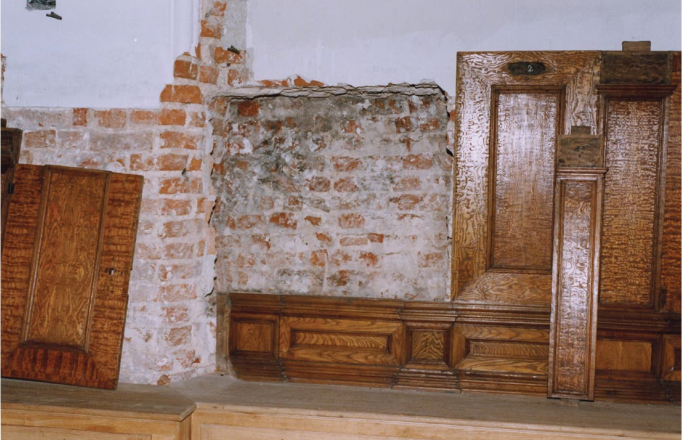
26. Ława św. Rajnolda podczas instalacji boazerii i rekonstrukcji siedzisk, 1993–1994, MG
